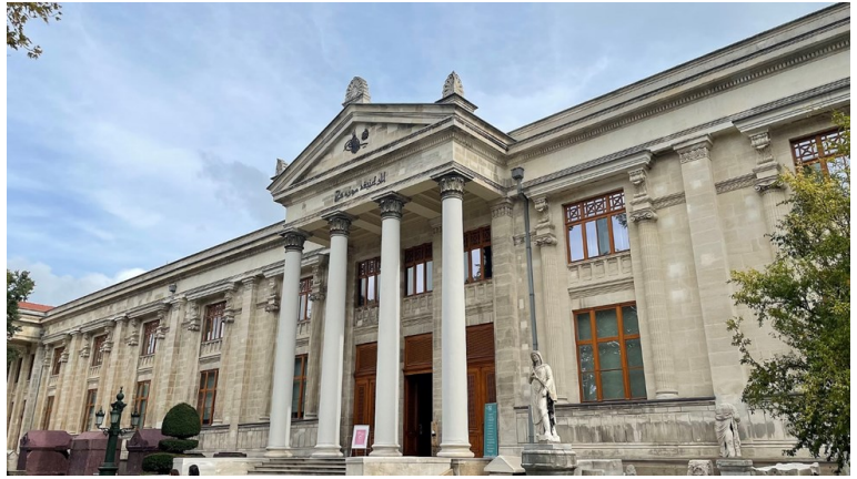
Müze-i Hümayun’un 1891 yılında inşa edilen ana binası
